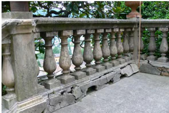
Fig.2: Il lato Est della balaustra sul pianerottolo della rampa di scale. Si osserva il basamento collassato e il corrimano interessato da fessurazioni.
