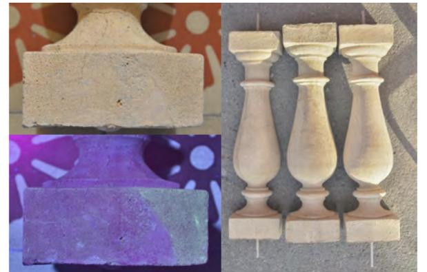
Fig.3: A sinistra, ricostruzione dello spigolo di un balastro tramite una malta selezionata, riconoscibile grazie alla fluorescenza UV. A destra, replica di un balastro (destra) e di un semibalastro (sinistra) a confronto con un balastro originale (centro).
